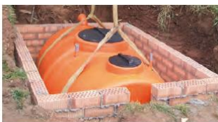
NECOR 5 vivienda unifamiliar
